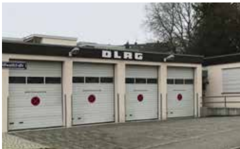
Garagenanbau mit vier Garagentoren
